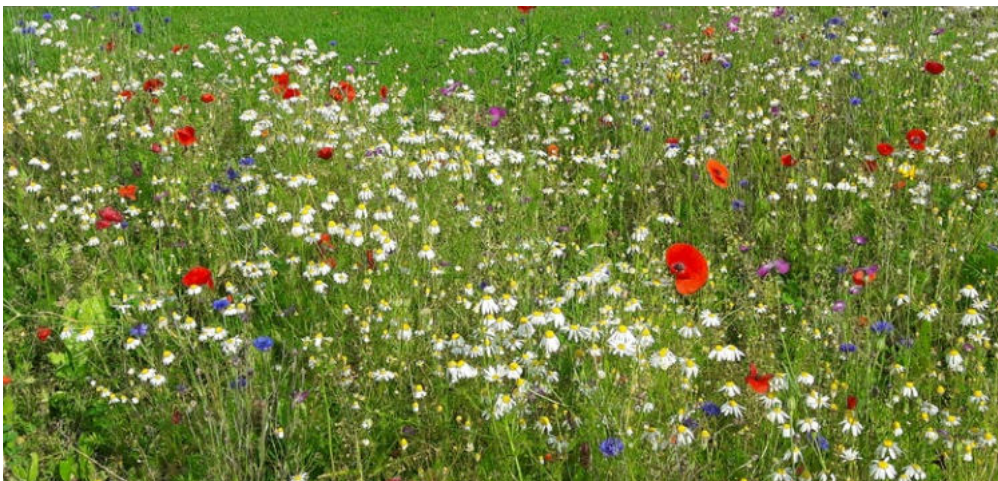
Abziehen der Vegetation mit einem Löffelbagger (oben); das ausgebrachte Saatgut der Lichtkeimer wird angewalzt (Mitte); buntes Ergebnis der Anlage einer Wildblumenfläche (unten)
